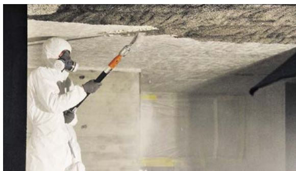
Die Decke im Eingangsbereich wird vollständig heruntergespitzt.
